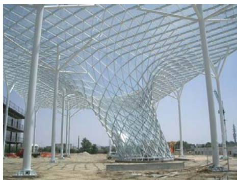
(a) Mesh triangolare della Vela della Nuova Fiera di Milano (2002-2005).
