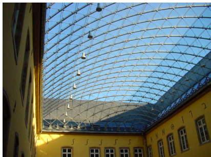
Figura: Copertura Abbazia Neumunster
