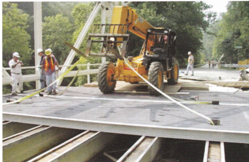
Fig. 1 - Sostituzione di una soletta di c.a. con pannelli di FRP [2].
