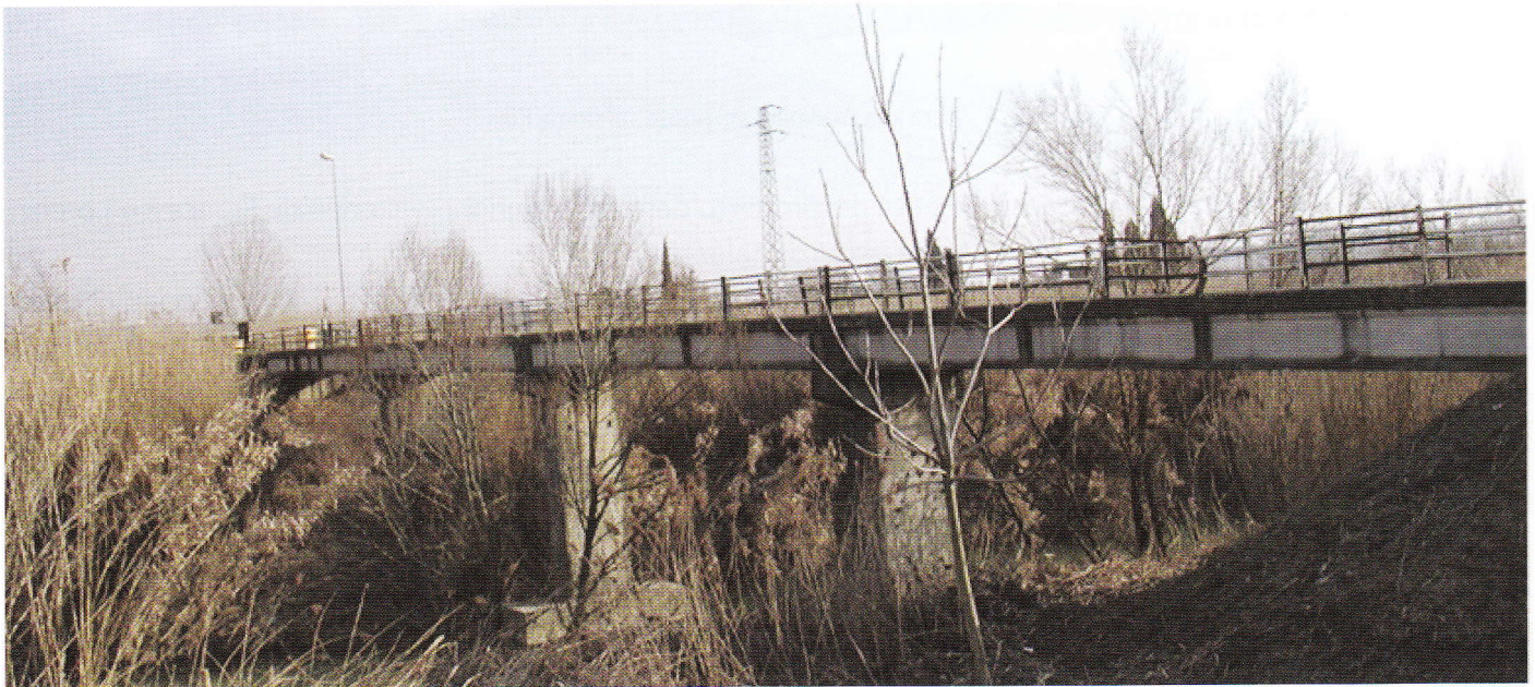
Fig. 3 - Il ponte sul fiume Elsa scelto come caso studio del progetto SUREBridge .
