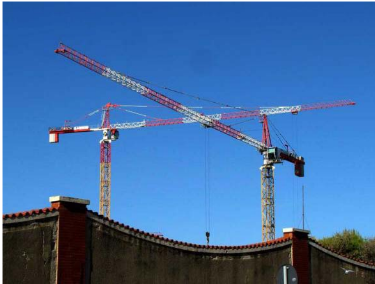
Gru da cantiere
