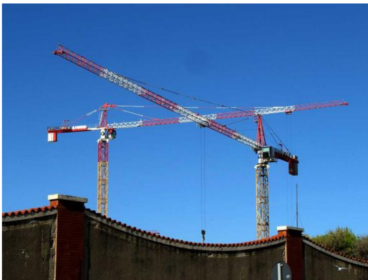
Gru da cantiere
