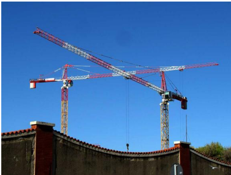
Gru da cantiere
